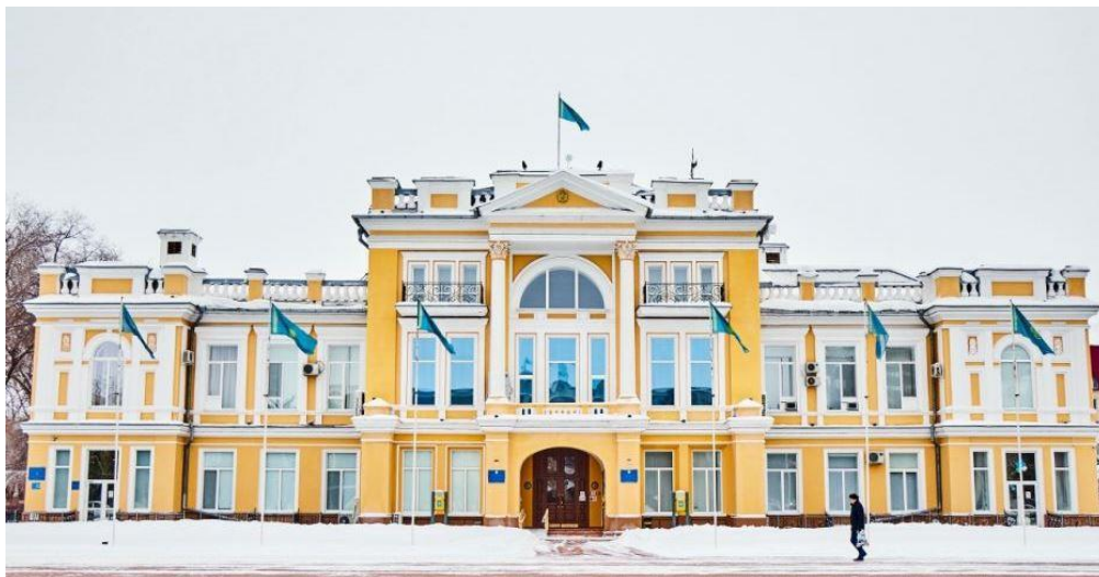
Рисунок 9.5 - Здание акимата Западно-Казахстанской области
