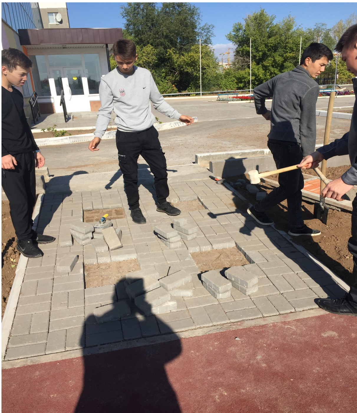
Рисунок 10 – Подготовка к благоустройству территории спорткомплекса ЗКАТУ им. Жангир хана с применением опытно – промышленной партии керамических брусчаток
