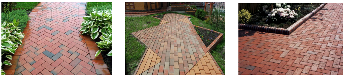
Рисунок 24 - Фрагменты тротуаров устроенных из керамических брусчаток и плиток
