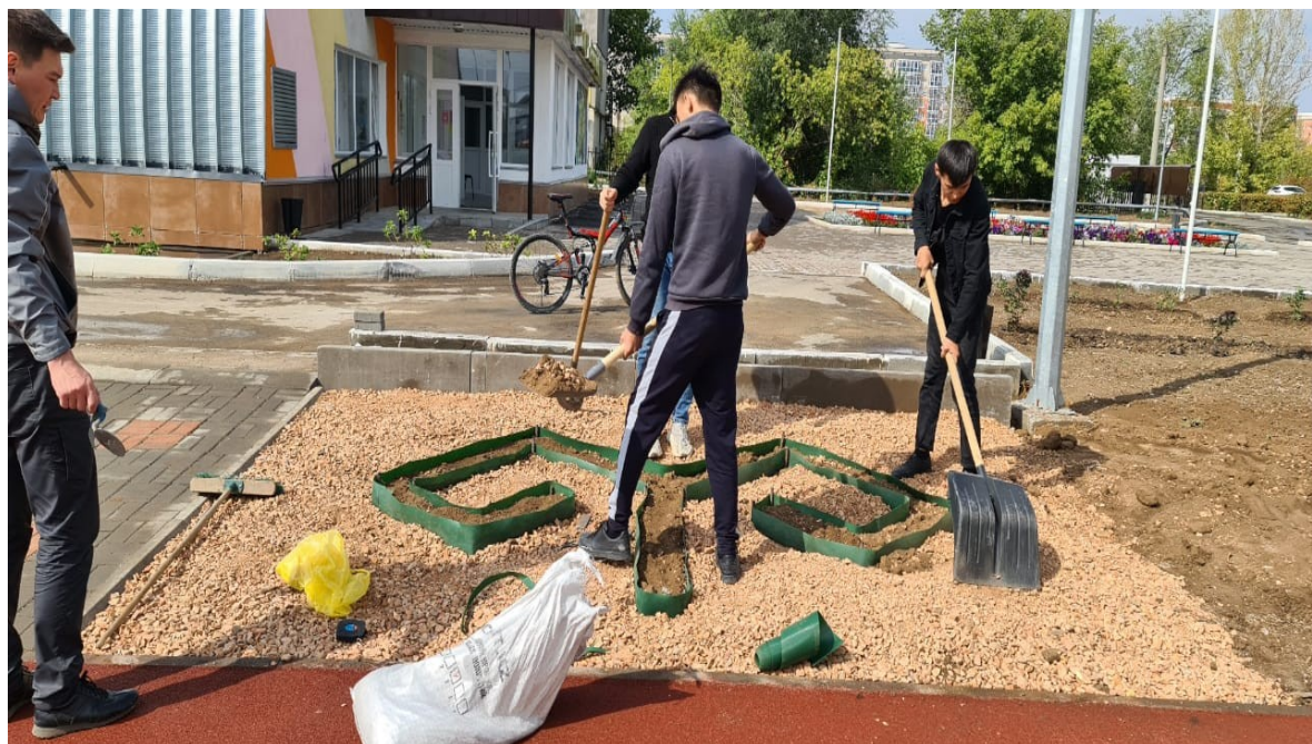
Рисунок 11 – Процесс благоустройства территории спорткомплекса ЗКАТУ им. Жангир хана с применением опытно – промышленной партии керамических брусчаток
