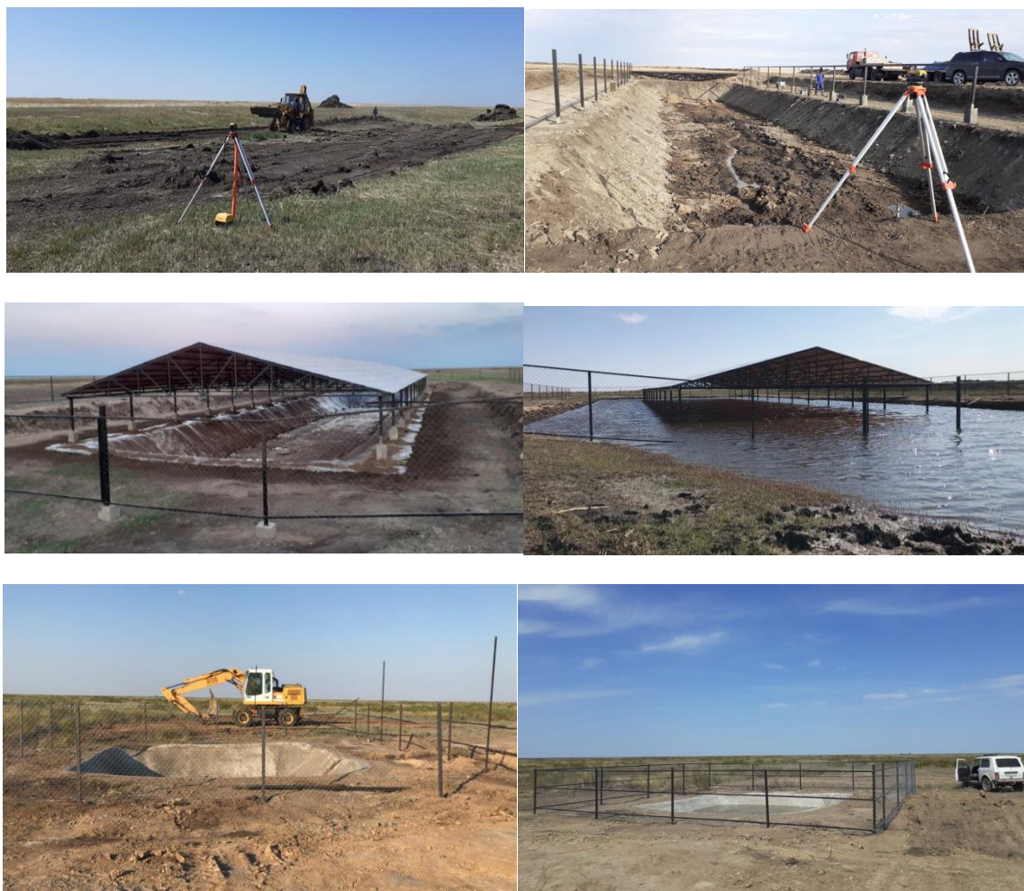
Рисунок 5 – Модульный контур искусственного водоисточника
