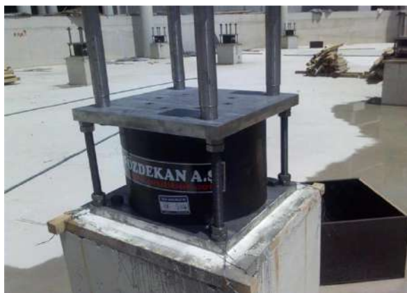
Рисунок 2 - Устройство сейсмоизолятора
