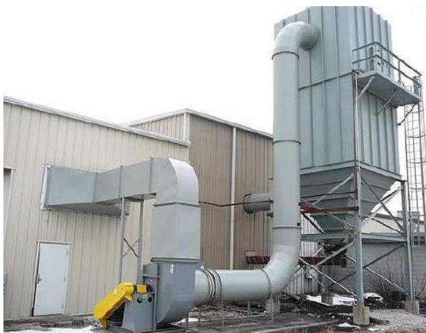
Рисунок 3 - Индустриальный рукавный фильтр.
