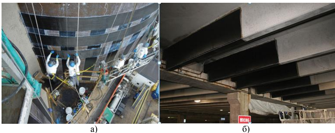
1-сурет – Көміртекті талшықтан жасалған кенептерді құрылыстың кез-келген пішіні үшін қолдануға болады
