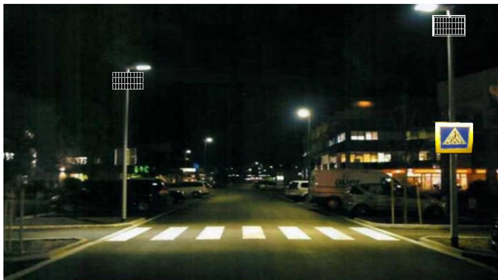
Сурет 1 – Күн батареясымен жарықтандырылған жаяу жүргіншілер жолағы
