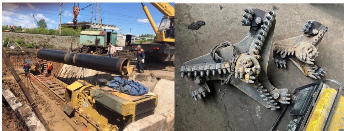
Рисунок 1 – Установка горизонтального шнекового бурения и режущие головки диаметрами 1200 мм и 700 мм
