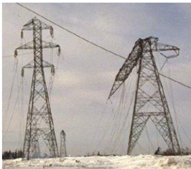
Сурет 5 – Көктайғақ салдарынан әуе желісінің бұзылған тіректері
