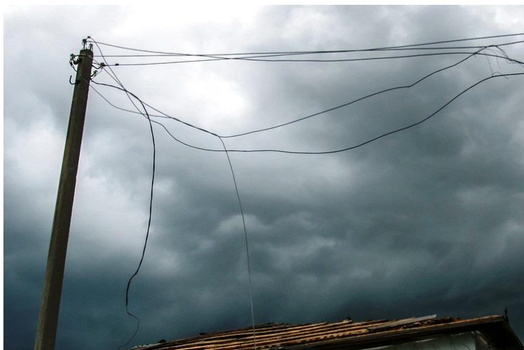
Сурет 3 – Желдің әсерінен сымның үзілуі
