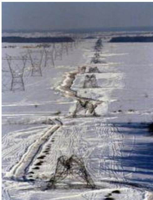
Сурет 4 – Көктайғақ кезінде электр беру желісі тіректерінің каскадты бұзылуы
