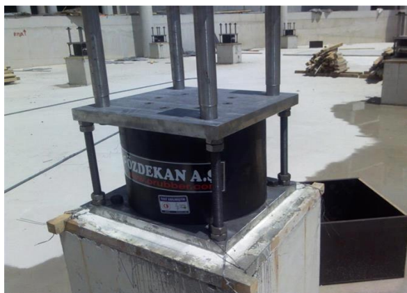
Рисунок 2 - Устройство сейсмоизолятора
