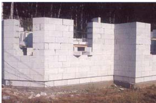
Сурет 1. Газдалған бетоннан жасалған үй құрылысының кезеңдері
