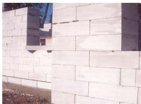
Сурет 1. Газдалған бетоннан жасалған үй құрылысының кезеңдері
