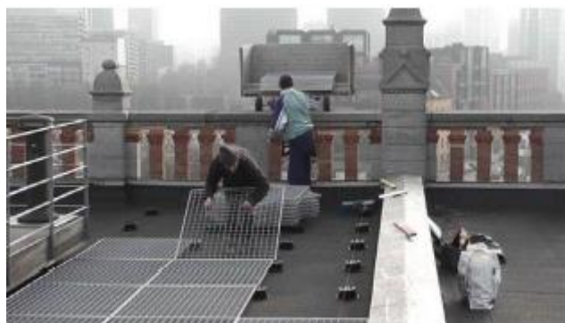
Сурет 5 – Тіректерге торлы төсемнің құрылысы
