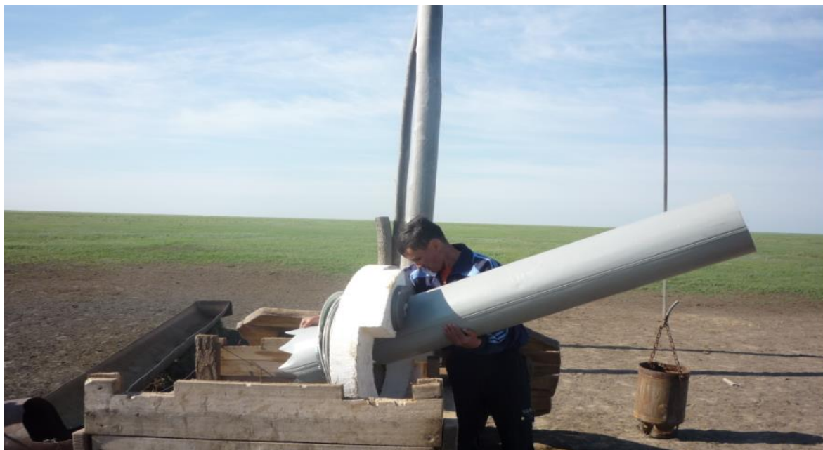
Рисунок 4.13 – Установка устройства поверхностного отбора воды
