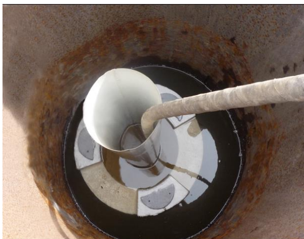
а) Положение устройства поверхностного отбора воды в колодце
