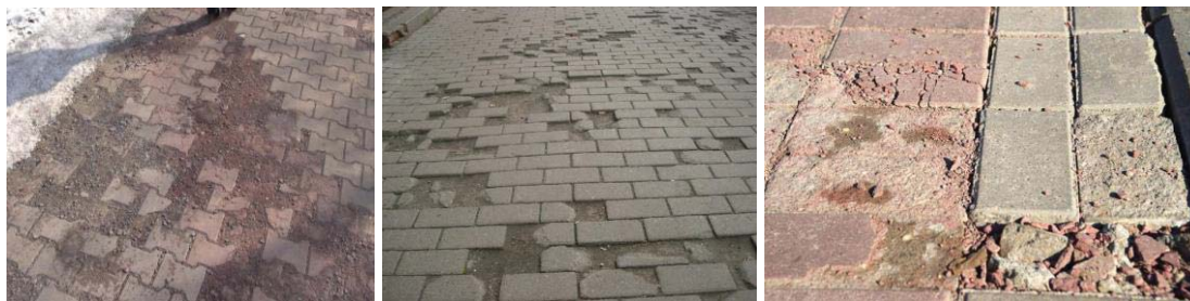
Сурет 1. Бетон төселген тастардан жасалған тротуарлардың бұзылуының үзінділері.
