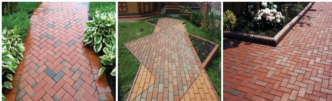
Рисунок 2. Фрагменты тротуаров устроенных из керамических брусчаток и плиток
