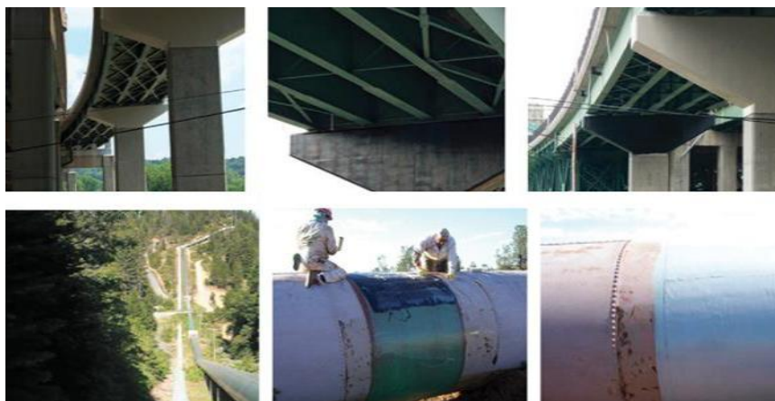
5-сурет - Нормативтік құжаттаманың өзгеруіне байланысты көпірдің көтергіштігін арттыру мақсатында CarbonWrap® көміртекті таспалармен күшейту жүргізілді (Нью-Хевен, Коннектикут, АҚШ) және CarbonWrap® сыртқы арматуралық жүйесін қолдана отырып болат құбырларды көміртекті ленталар негізінде жөндеу.
