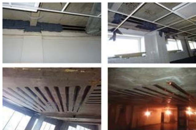
4-сурет – Богучан алюминий зауытының тұтас құймалы темірбетон арқалықты төбе жабындарын нығайту (АҚ «РУСАЛ»)
