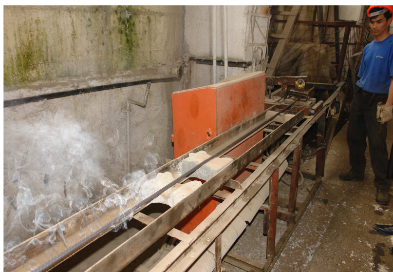
Рисунок 2 – Электротермическое натяжение арматуры и формирование покрытия на арматуре
