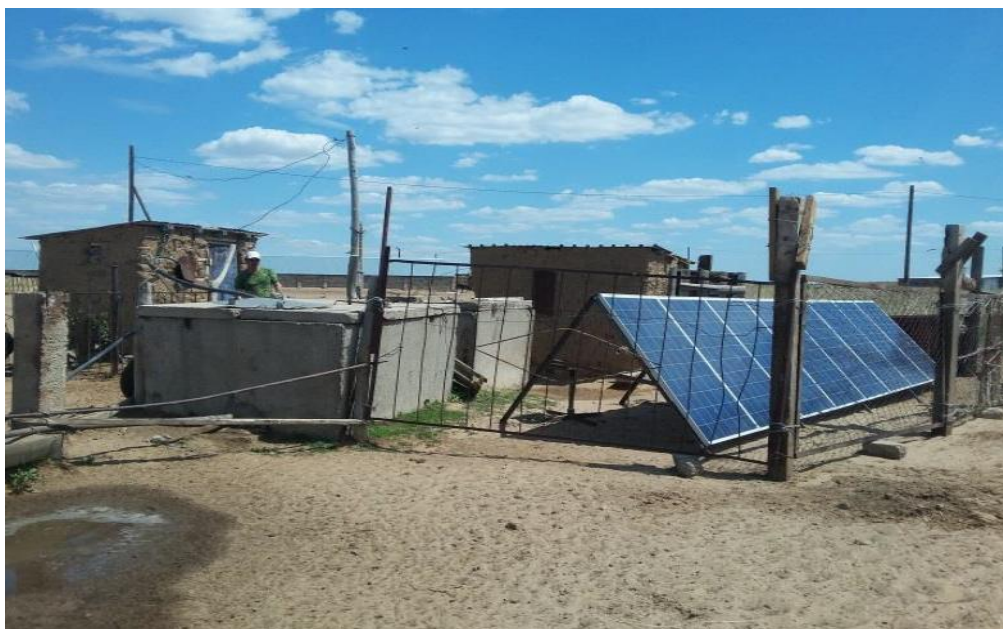
2 сурет - Шаруа қожалықтарындағы ұнғымалар мен құдықтарды электр қуатымен қамтамасыз ететін күн батареялары
